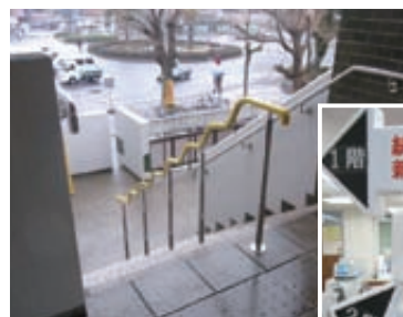
↑階段手すり (中央図書館)
