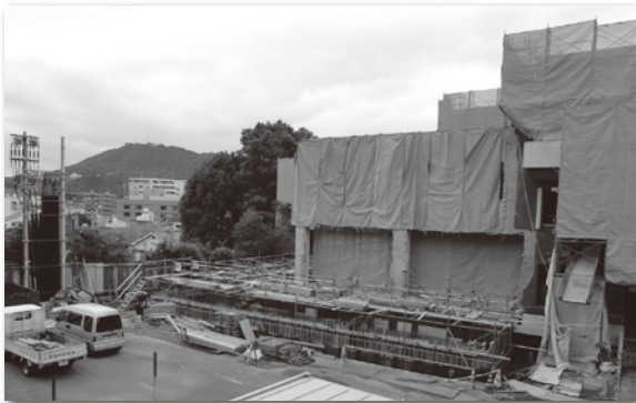
増築工事中の医学分館書庫（11月11日撮影）
