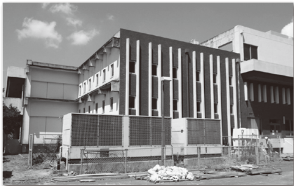
工事前の医学分館書庫。手前が増築予定（8月28日撮影）
