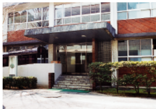
経済学部分館外観
